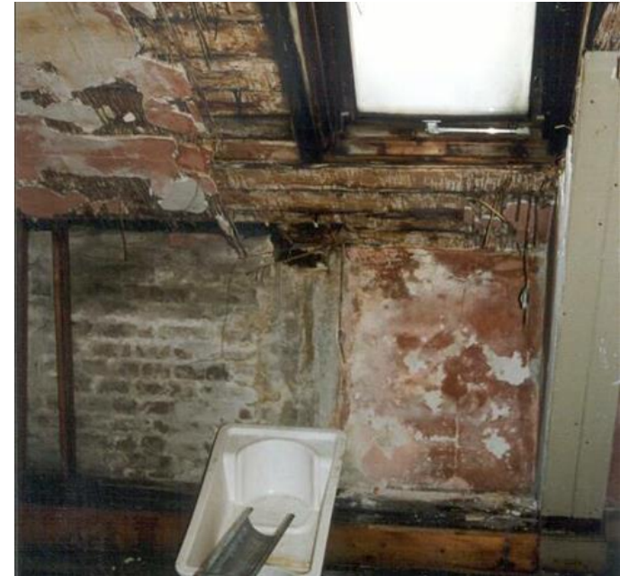
△ Vedligeholdelse og brugeradfærd
